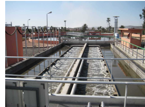
Station d'épuration de Marakech
