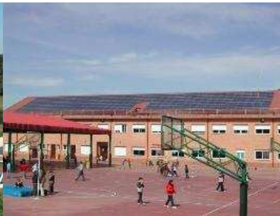
Solar Fotovoltaico en Infraestructura pública
