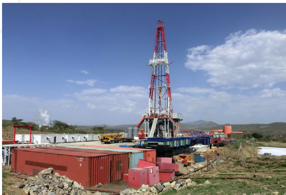
Anillo de perforación geotérmica de KenGen, Olkaria, Kenya
